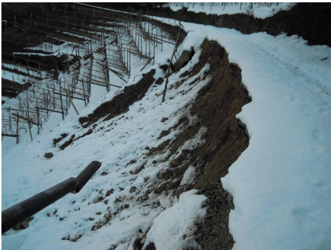
Foto 5.2. Il muro di valle franato che ha coinvolto la strada comunale Fontana, p.f. 4164/2
