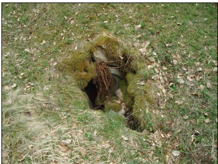
Esempio di area di depressione con fosso drenante e scarico per superare il rilevato stradale
